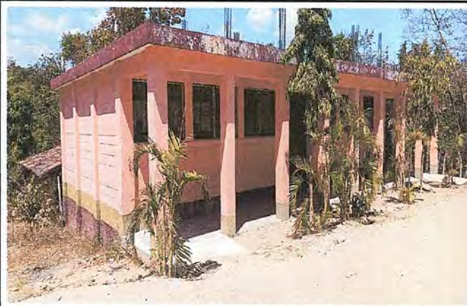
Foto 3: Vista general del modulo 1 y 2 de aulas. Mejoramiento de cuneta de concreto para desviar agua pluvial.
