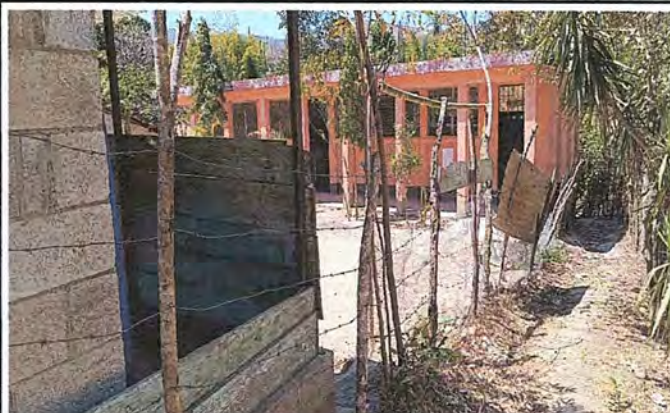
Foto 2: Vista general del centro educativo. Se prioriza mejoramiento de cerramiento perimetral.
