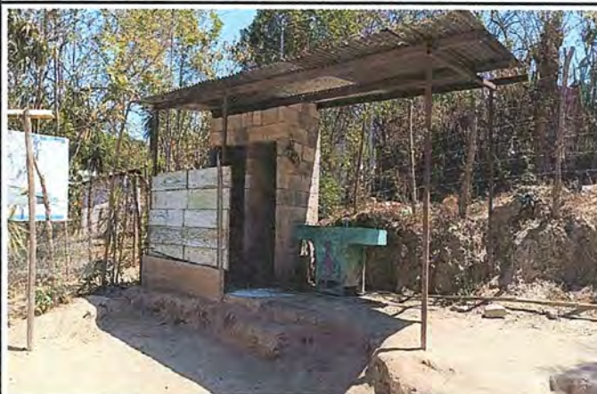
Foto 4: Vista general de servicios sanitarios. Mejoramiento y reparación de servicios sanitarios y sus accesorios.
